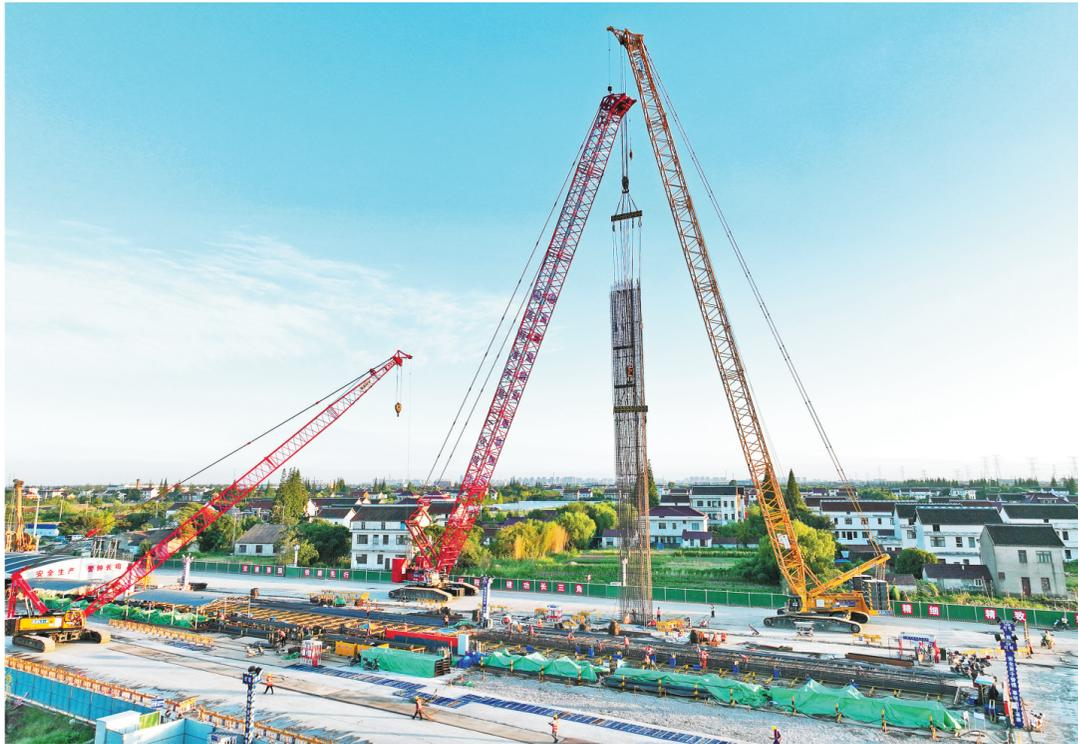
1月21日,随着海门北站C区最后一幅地下连续墙钢筋笼入槽和浇筑混凝土,中铁一局沪渝蓉高铁项目一分部海门北站A、C、E区地363幅地连墙工程顺利完工,标志着海门北站核心区节点目标取得重大胜利。在施工过程中,项目负责人亲自落实督办,简化流程、强化监管,在保证安全可控、质量优良的前提下,加班加点进行施工作业,全体干部职工各司其职、通力协作,确保了节点施工任务的顺利推进。图为沪渝蓉高铁海门北站C区最后一幅地下连续墙钢筋笼入槽作业。
