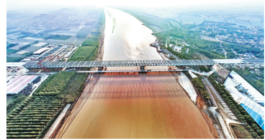
俯瞰桥面已贯通的聊泰铁路黄河公铁桥。
