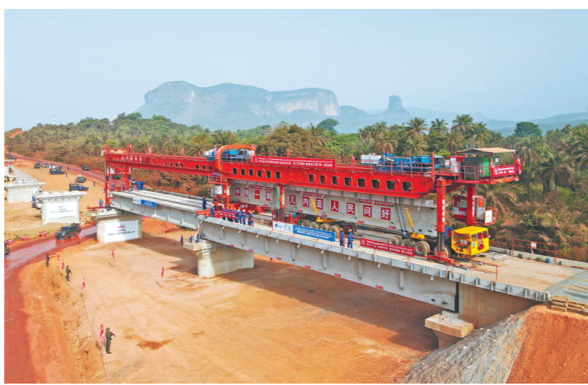
马西铁路架梁。
