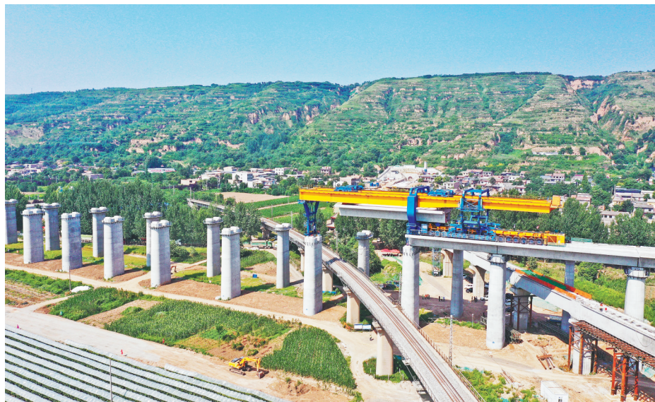
8月6日下午,随着JQ900B型架桥机将一孔长32米的箱梁稳稳架设在跨越西康铁路沙河特大桥50#-51#桥墩上,标志着中铁一局西康高铁长安梁场经过连续两天的架梁封锁施工,顺利跨过西康铁路既有线。(通讯员 段冰涛 徐光 摄影报道)
